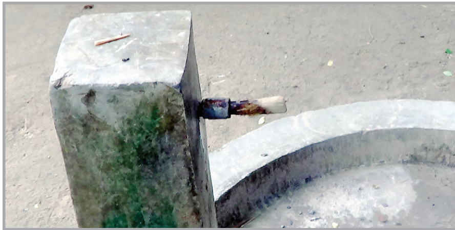
पूर्णिया के श्रीनगर प्रखंड में टूटी हुई नल में लगा लकड़ी का टैपी.
